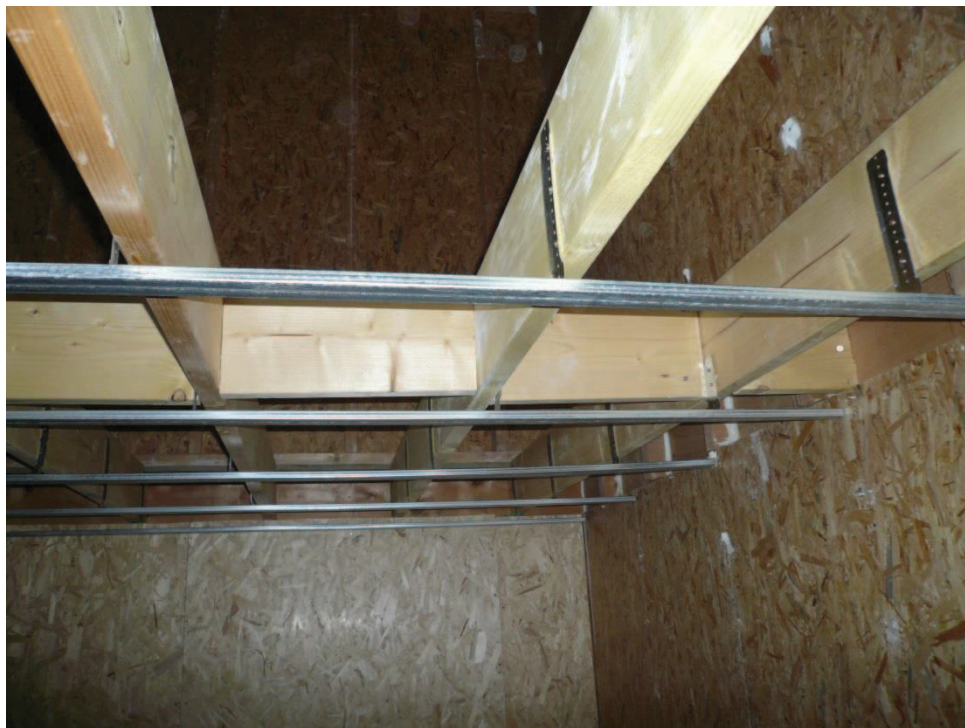
Figure B.5 : Photo des suspensions et rails pour le montage du plafond en cours de pose.
