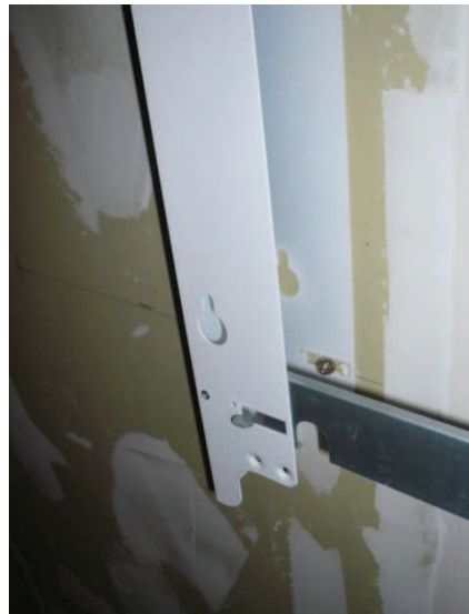
Figure 2 : Support de fixation de la chaudière murale.
