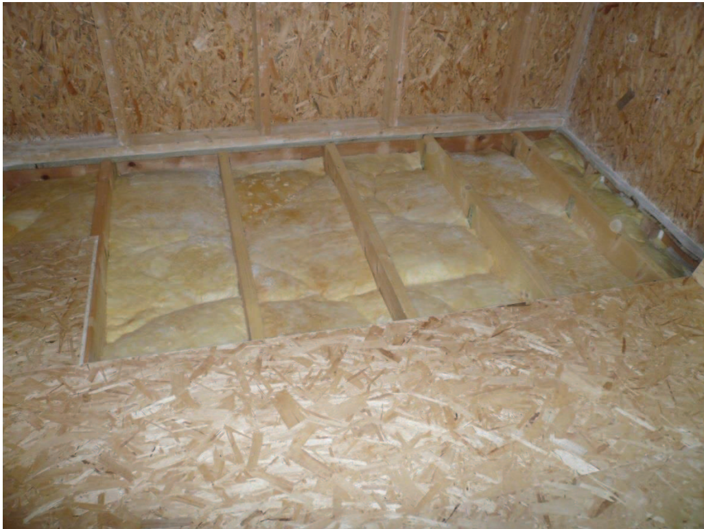
Figure B.6 : Photo des plaques d'OSB de 18 mm en cours de pose.
