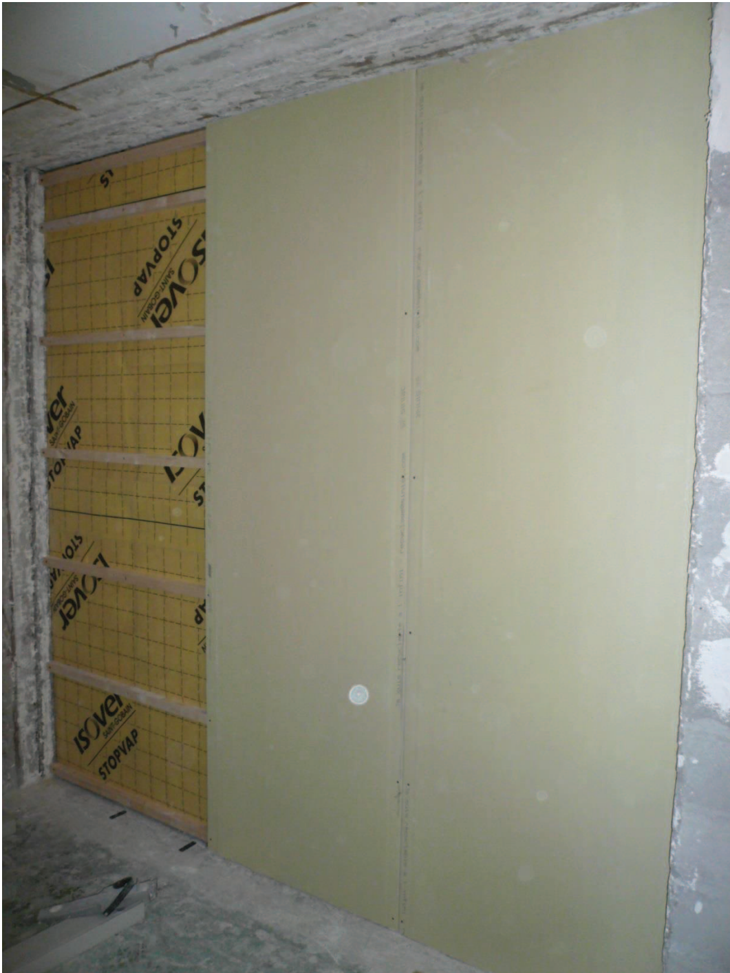
Figure A.5 : Montage de la façade dans le laboratoire et mise en œuvre du parement en plaques de plâtre BA18 sur tasseaux bois.
