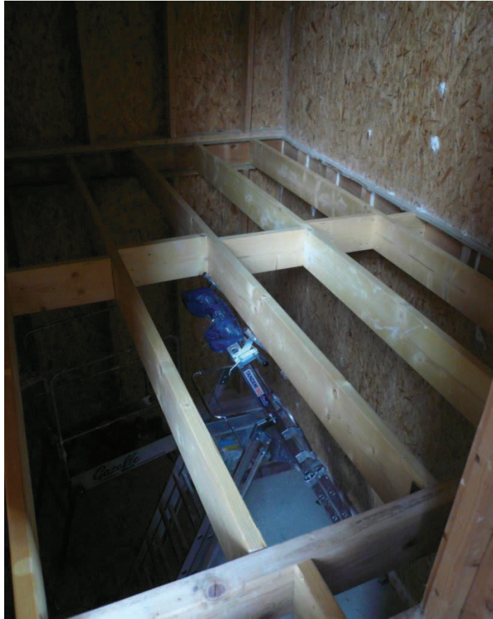
Figure B.4 : Photo du solivage du plancher en cours de pose.
