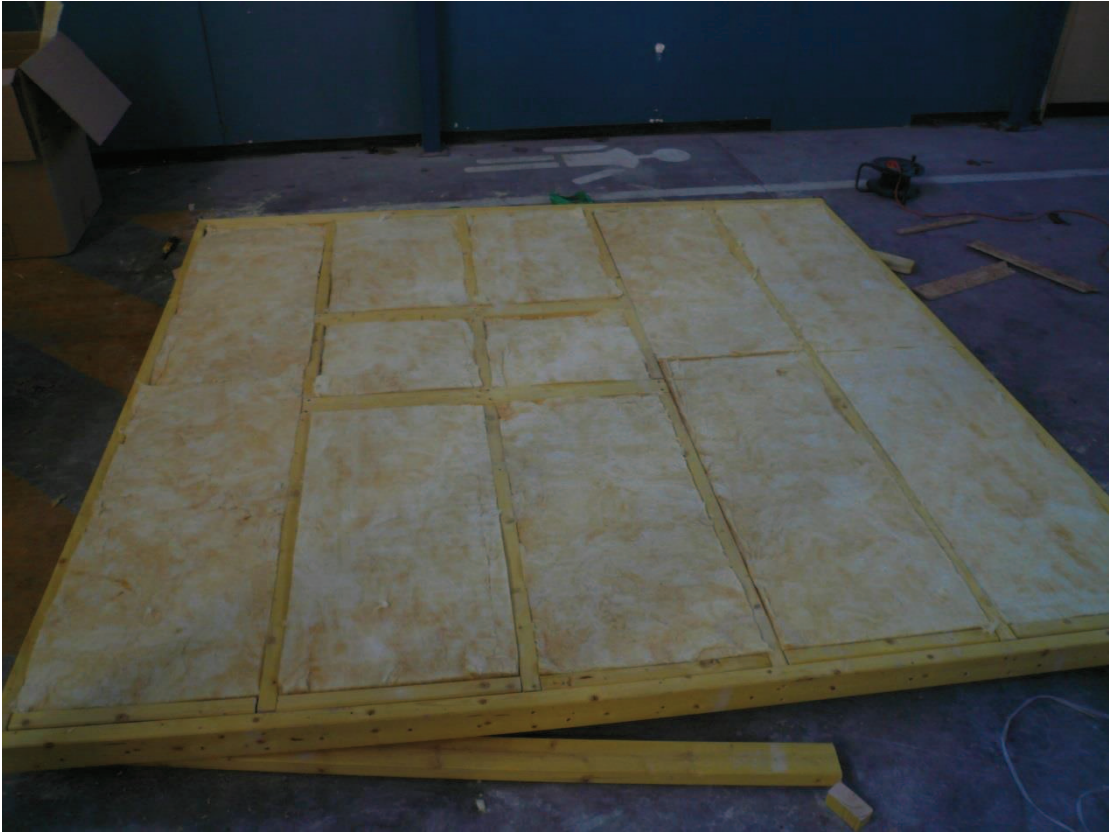
Figure A.4 : Réalisation de la façade avec les renforts d'ossature pour le montage de la chaudière murale.
