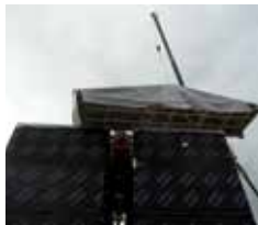
Installation de la toiture provisoire
