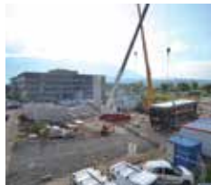
Fin d'assemblage du bâtiment
