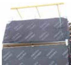
Positionnement et centrage du module
