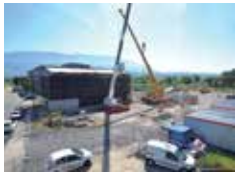
Livraison de 2 modules par convoi exceptionnel
