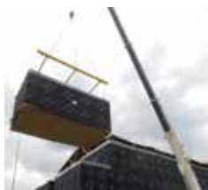
Pose par grue mobile
