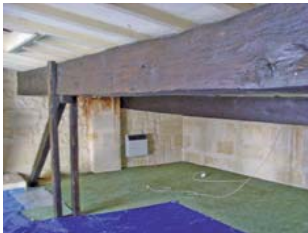
Combles habitables non exploités avant travaux (Source FCBA)
