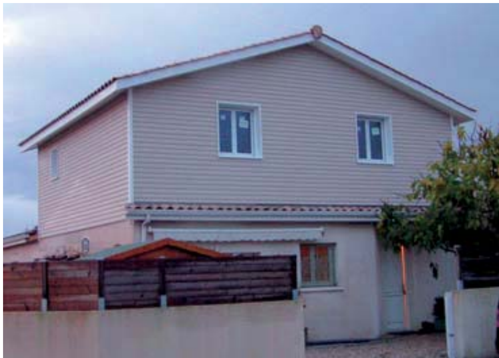
Surélévation partielle d'une maison individuelle (Source FCBA)
