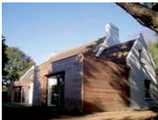
Extension en ossature bois (Source CNDB)
