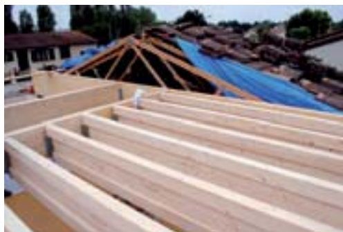
Création d'un plancher en surélévation partielle avec mise en place d'un porteur BLC et de solives en poutres en I (Source France Poutres)
