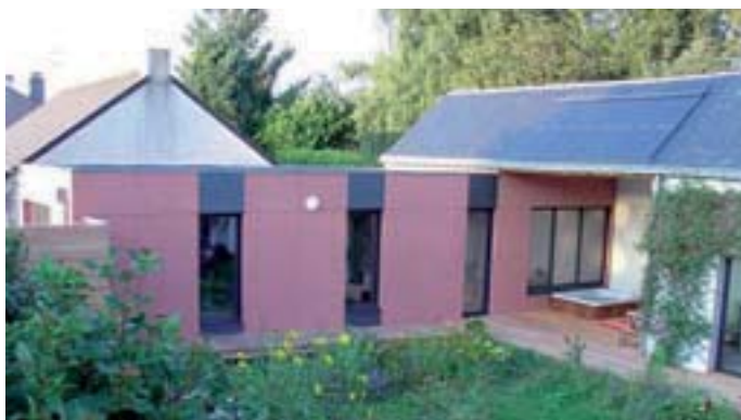
Extension en ossature bois (Source CNDB)
