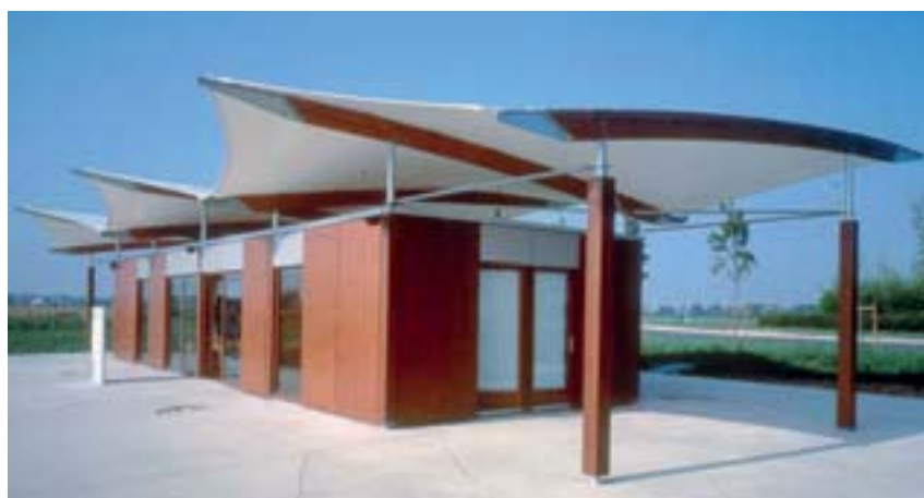
Bardage en panneau NF Contreplaqué extérieur CTB-X (Source FCBA)
