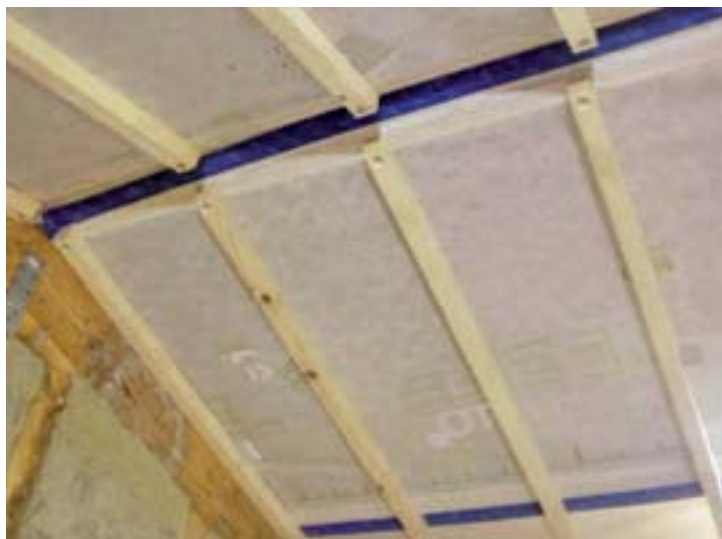
Film pare-vapeur en rampant (Source FCBA)
