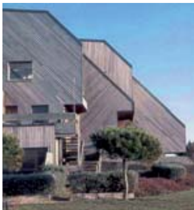
Bardage en lames (Source FCBA)
