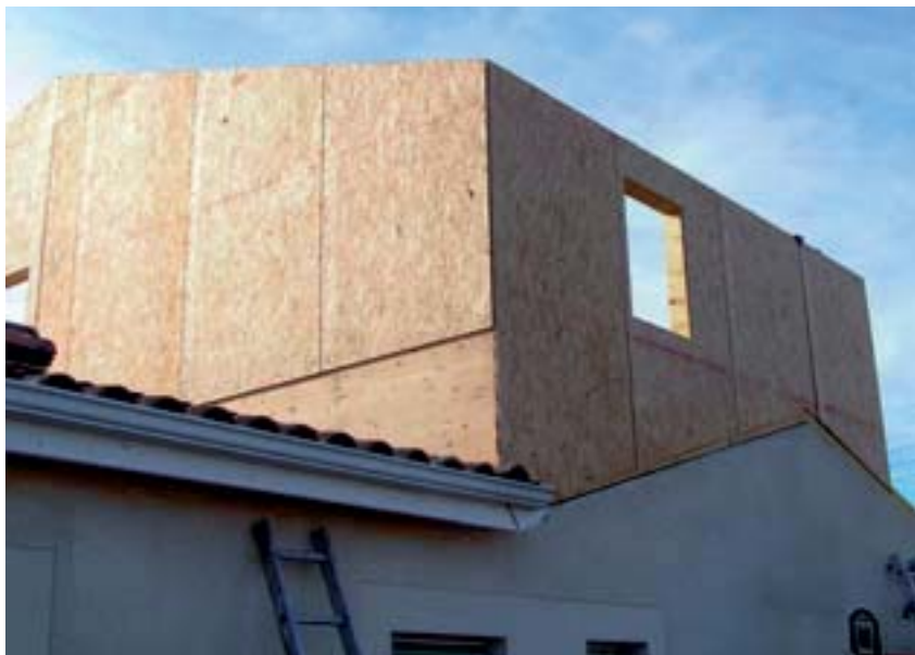
Pose des panneaux à ossature bois avec conservation des pignons (Source FCBA)
