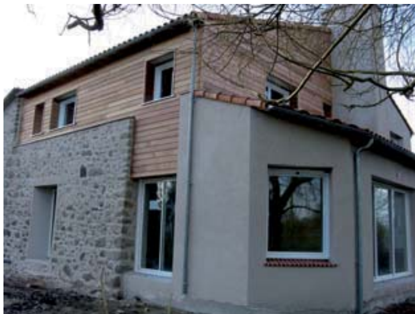
Exemple de surélévation en ossature bois (Source Sté Onillon)
