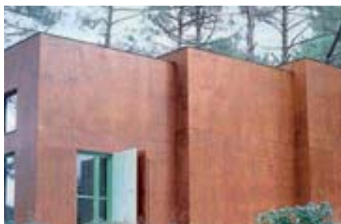
Bardage en panneau de contreplaqué (Source FCBA)
