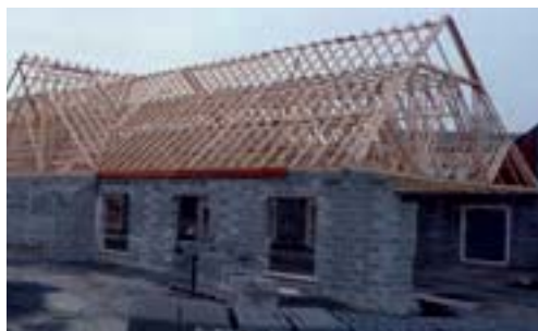
Charpente industrielle à combles perdus (Source FCBA)
