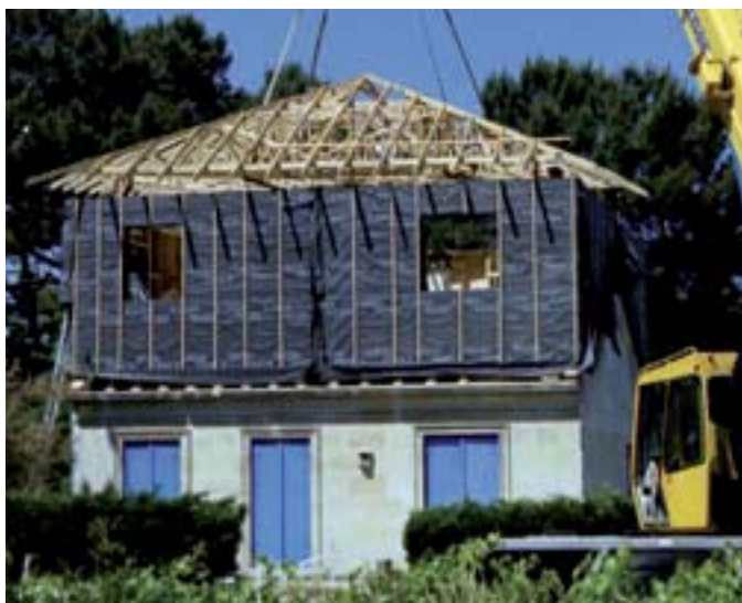
Travaux de surélévation totale d'une maison individuelle (Source FCBA)
