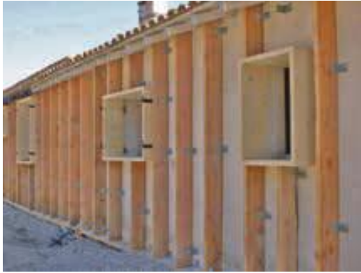
Isolation thermique par l'extérieur (Source FCBA)
