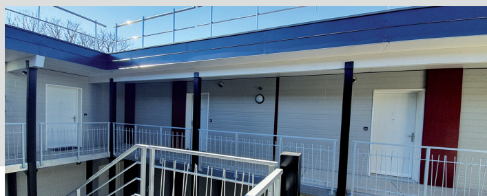
Les accès sont réalisés par des coursives métalliques dans le patio
