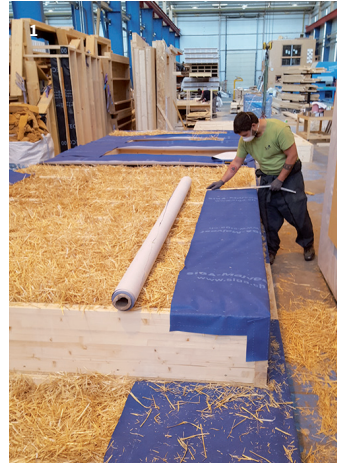
1_ Remplissage des panneaux par de la paille. 2_ Les accès sont réalisés par des coursives métalliques ; un bac métallique en sous face assure l'étanchéité à l'eau.
