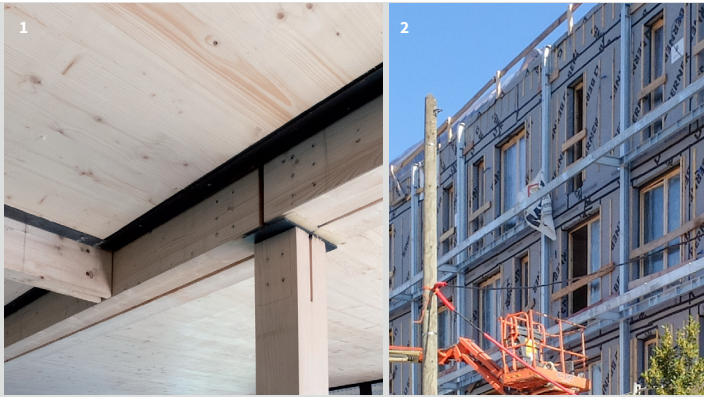
1_L'association du CLT et des profils HEA permet de diminuer l'épaisseur des planchers 2_ Les balcons sont désolidarisés et composés d'une structure métallique et d'un platelage bois
