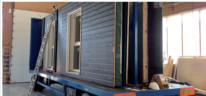
1_ La découpe des panneaux et le clouage sont effectués sur une ligne de fabrication. 2_ Les panneaux sont acheminés sur chantier et associés par des connecteurs métalliques.
