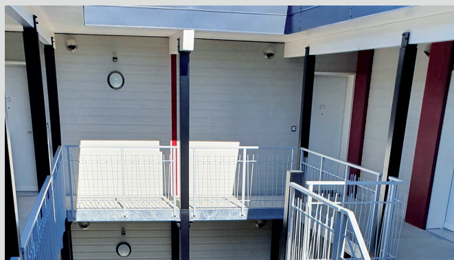
Coursives d'accès par l'extérieur.
