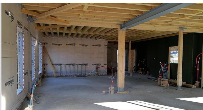
Solivage des plafonds et reprise de charge par des poteaux bois
