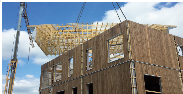
Levage de la charpente, après assemblage au sol
