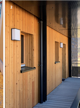
1_ Remplissage des panneaux par de la paille. 2_ Les accès sont réalisés par des coursives métalliques ; un bac métallique en sous face assure l'étanchéité à l'eau.
