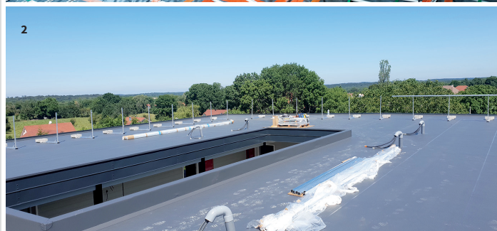
1_Le chauffage est réalisé par des câbles chauffants électriques. 2_Une membrane assure l'étanchéité de la toiture terrasse chaude.
