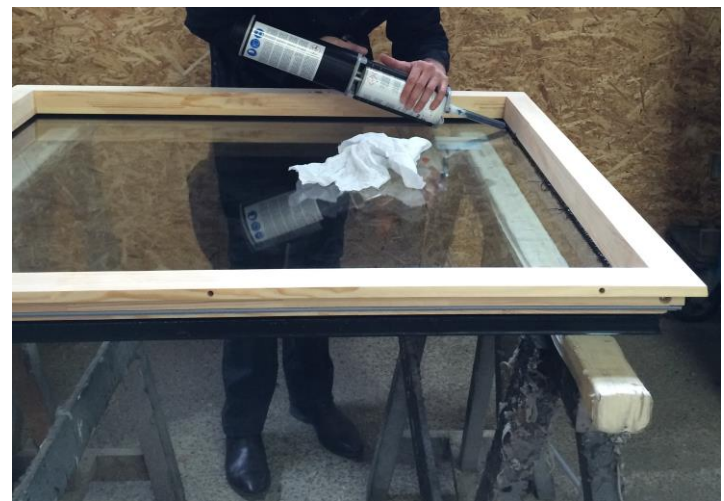
Photo 1 : Opération de collage du vitrage sur lun cadre ouvrant bois
