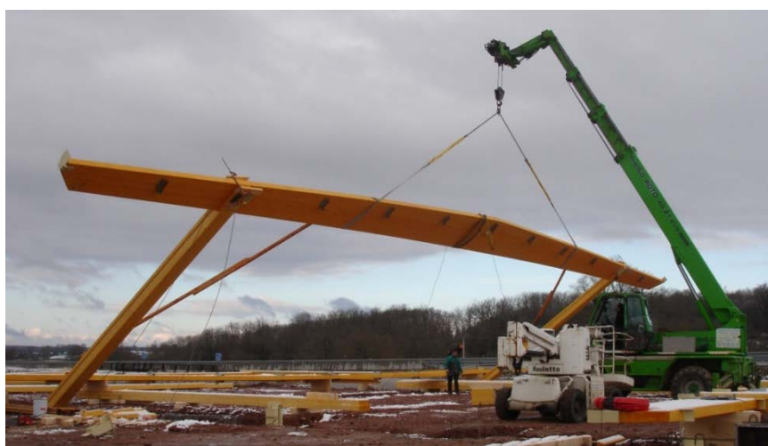
Photo 2: Levage de portique
