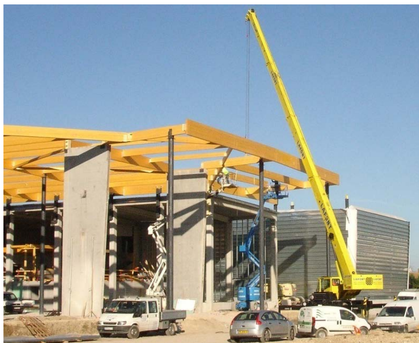
Photo 1 : Levage de panne
