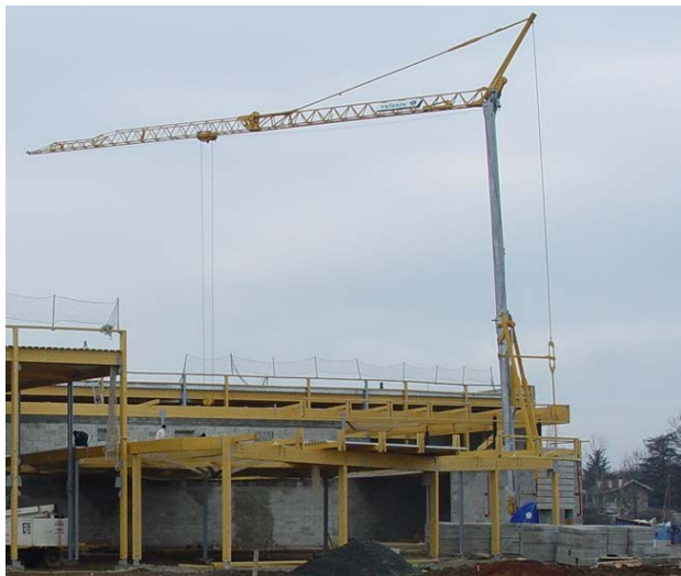
Photo 12 : Grue à tour (GMA) Portée 21m, charge en bout 700 kg
