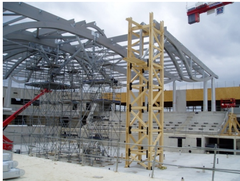
Photo 27 : Tours d'étalement et sapine
