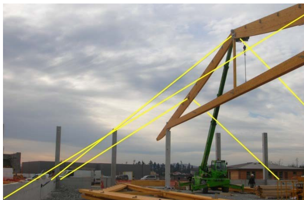
Photo 23 : Stabilité provisoire d'une ferme latine de portée 40m
