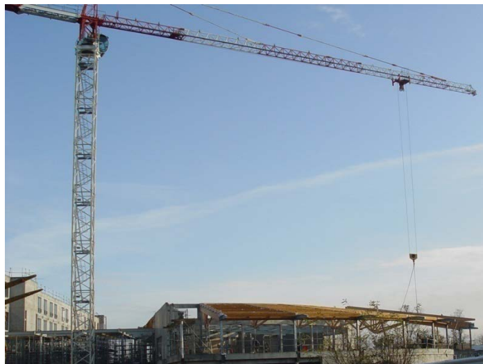
Photo 13 : Grue à tour (GME) Portée 55m, charge en bout 4750kg
