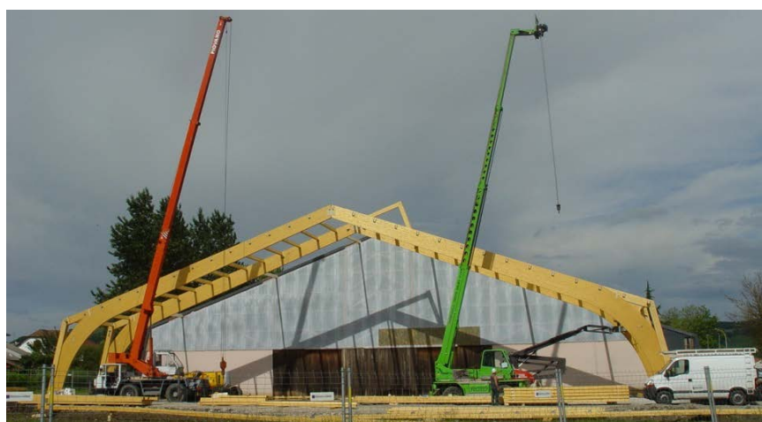
Photo 3 : Levage d'arcs à 3 articulations.
