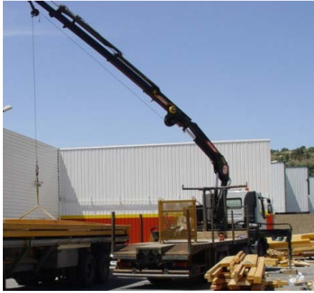
Photo 9 : Grue auxiliaire sur camion : Exemple : Grue 9T.m, flèche 20m
