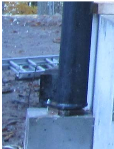
Photo 33: Calage provisoire de pied de poteau métallique
