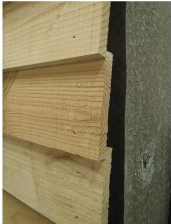
Photo 18 : Réalisation du collage de pare-pluie sur la paroi béton
