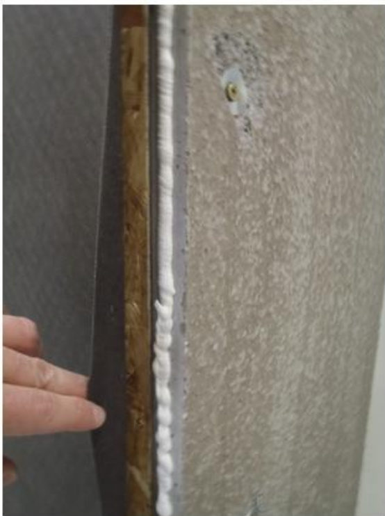
Photo 18 : Réalisation du collage de pare-pluie sur la paroi béton
