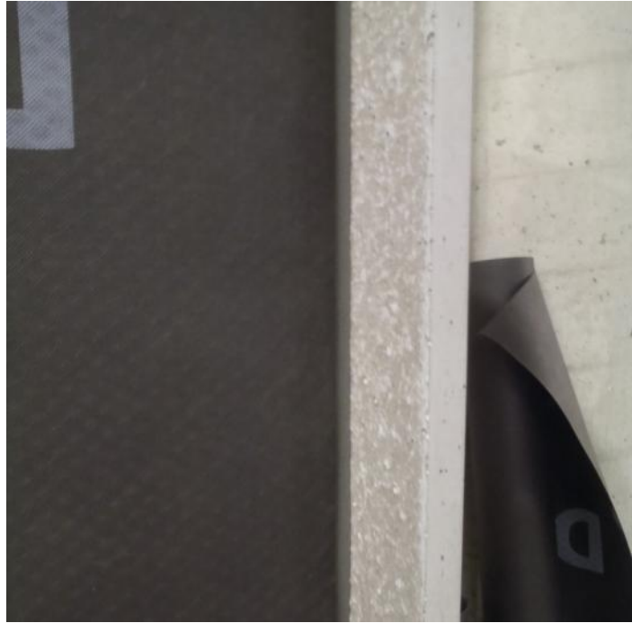
Photo 15 : Aperçu de l'état de surface des parois béton
