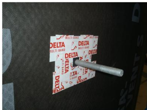
Photo 12 : Montage de la maquette n°4 / Traversée de la tige filetée Ø 16 mm
