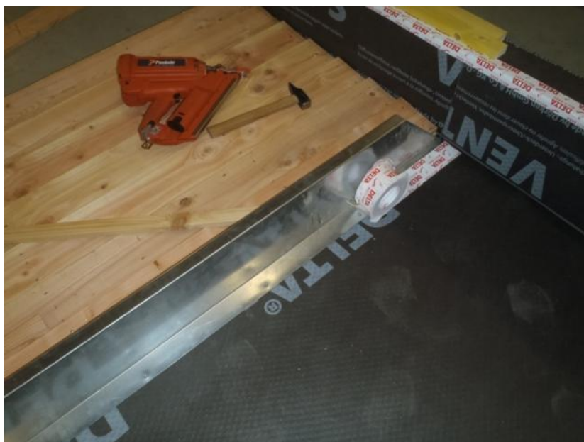
Photo 10: Mise en œuvre de la bavette avec pontage au ruban adhésif
