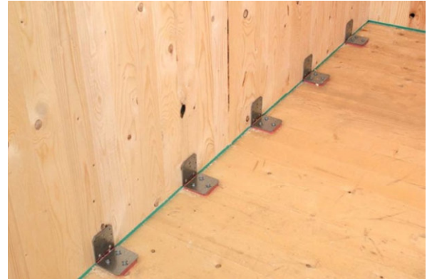
Équerre (à gauche) et mise en œuvre (au-dessus)
