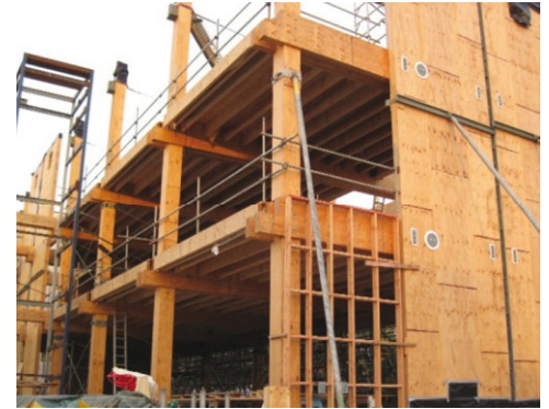
Bâtiment NMIT de 3 étages avec murs post-contraints (sur la droite)
