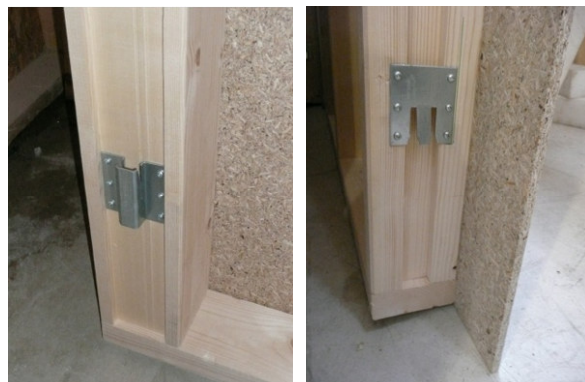
Parties mâle et femelle installés sur les montants de murs prêts à être emboîtés
