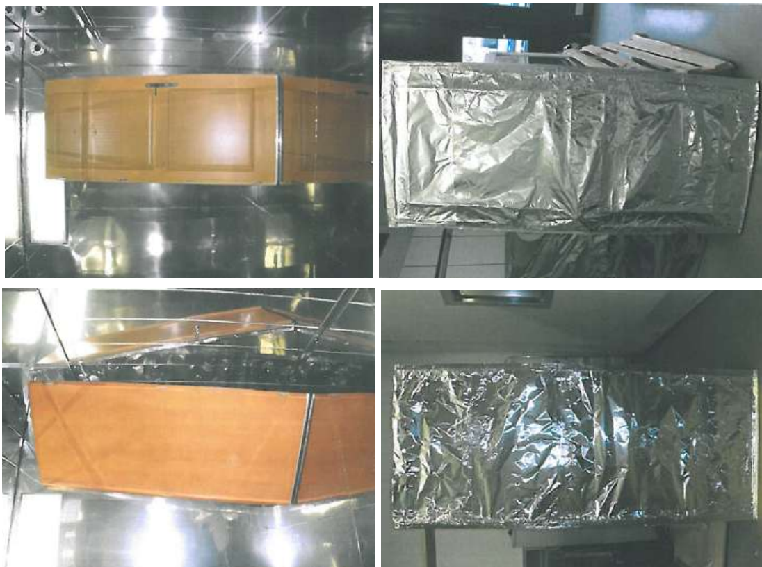
Figure 22 : Exemples de portes colmatées (haut : 12/1125R/12-1 ; bas : 12/1125R/18-1)
